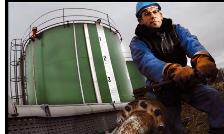
Les cuves de stockage de la société Toreador Energy France représentent 1300 mètres cubes de pétrole brut.
